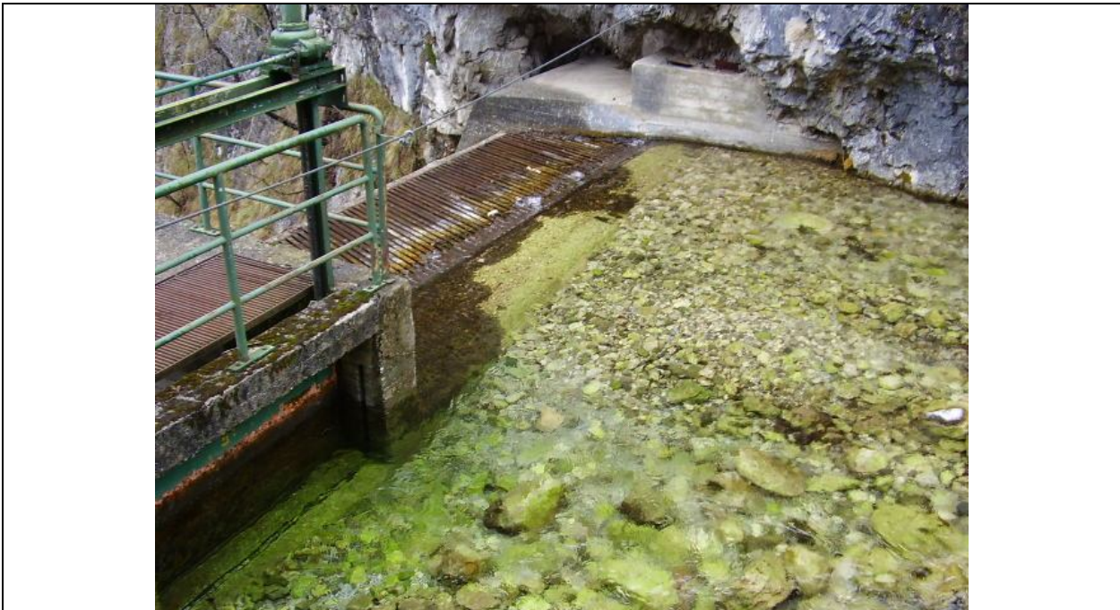
Figura 17. Opera di presa sul Palvico.
