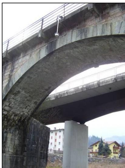
Sezione di misura Ponte Arche.
