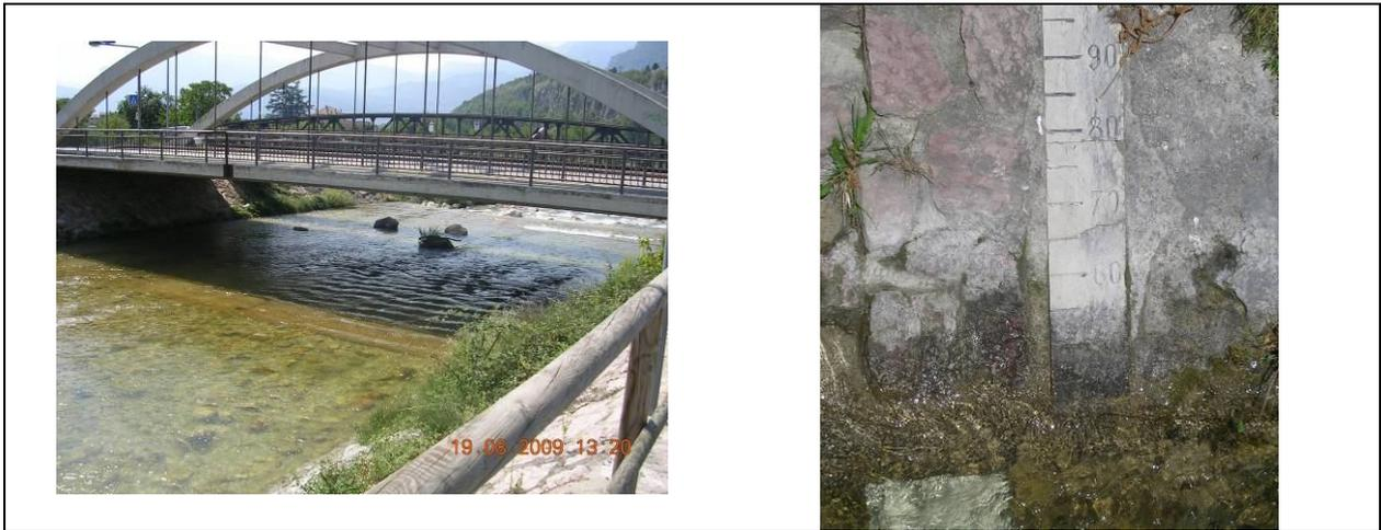
Sezione di misura sul torrente Leno a Rovereto e particolare dell'asta.
