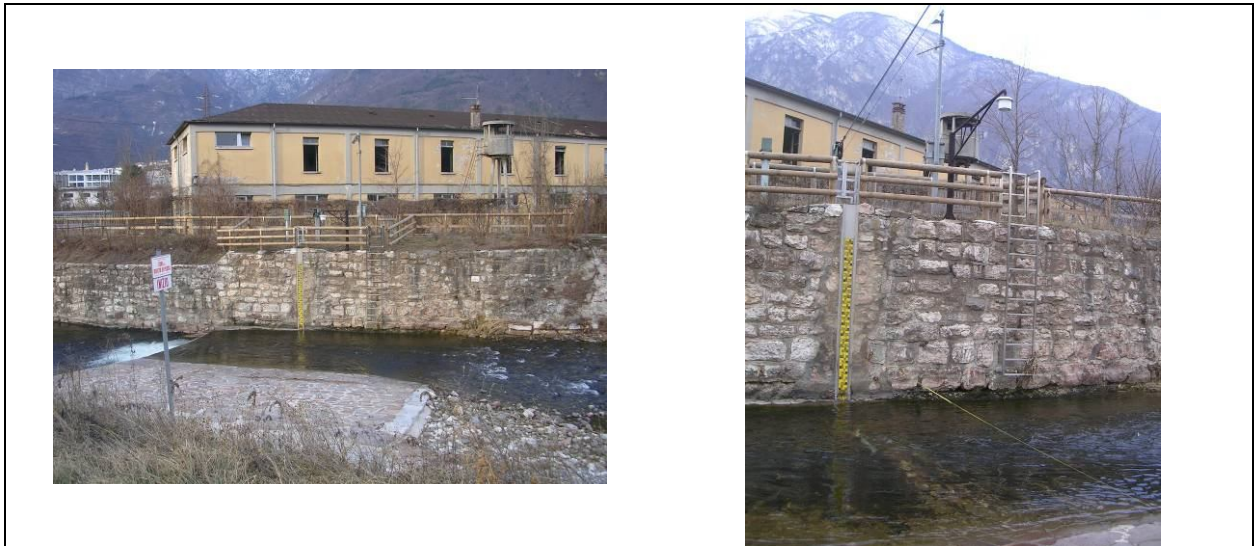
Idrometro e sezione di misura sul Fersina a Trento.
